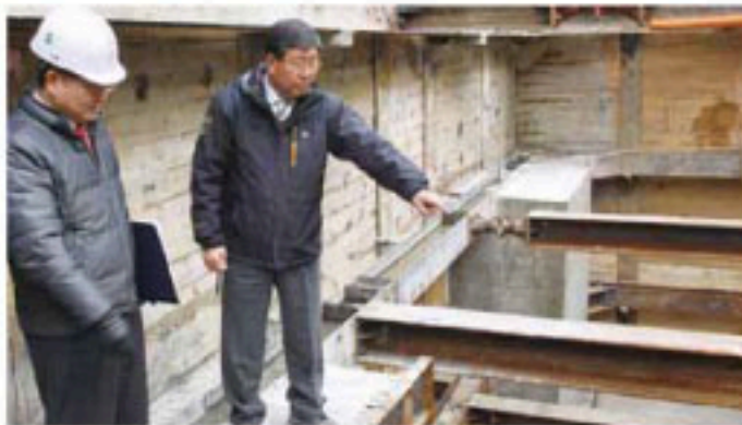
자양2동 낙천정 지하보차도 분리 공사장 현장 점검
